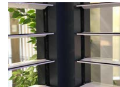
Les lames s'orientent afin d'optimiser au mieux le passage de la lumière.
