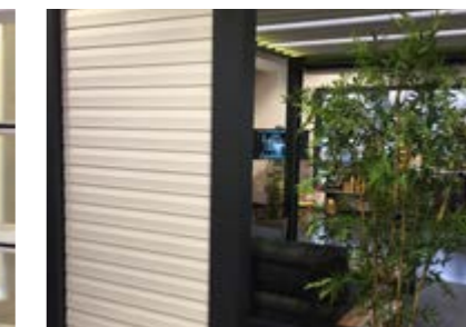
Les lames s'orientent afin d'optimiser au mieux le passage de la lumière.
