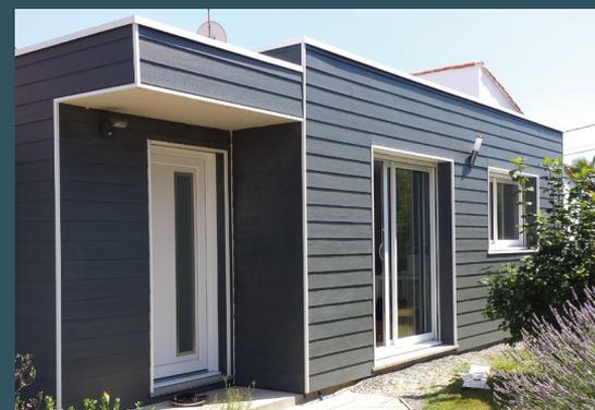
Exemple de lames d'un pas de 180 mm
