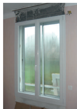
Pose de la nouvelle fenêtre PVC
