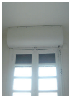
Volet roulant et fenêtre avant rénovation
