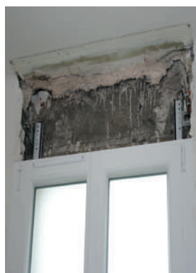
Mise en place des glissières du volet roulant
